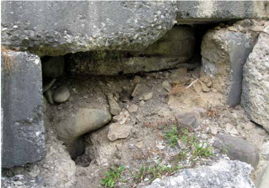
ნახ. 7.4 უჩავის გამამდიდრებელ ფაბრიკასთან ახსებული საჩკოფაგის კედლის ძიხი (მდ. ღუხუნისწყლის მახვივანა ნაპირი), კედლის დაშოხება მდინაჲის წყლის ზედაპირიდან (ზაფხულის პეჩიოდში) – 3-4 მეტრი
