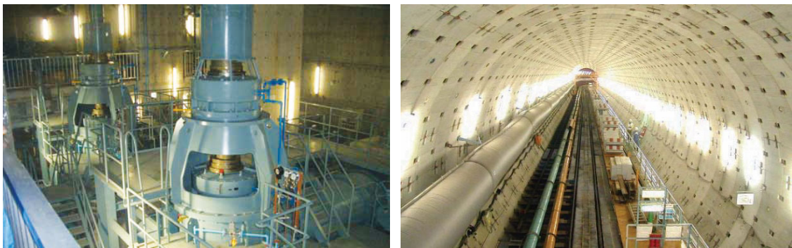
სურ. 2.6. წყლის სატუმბი სადგური და წვიმის წყლის მიმღებ-გამტარი დახურული არხი-მილსადენი
